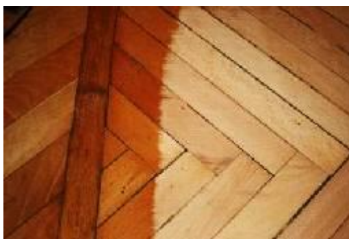
Figura 1: trattamento di sgrossatura. La parte più chiara ritrae il parquet grezzo sgrossato.
