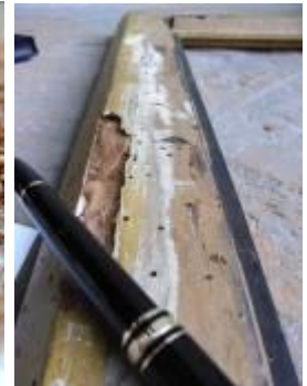
Fori di sfarfallamento
